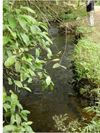
Conduit to intake
