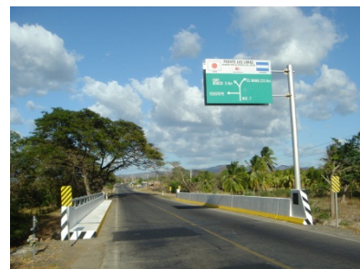
Las Limas Bridge
