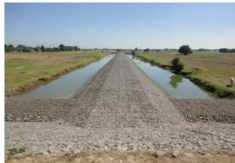
T-head spur dike
