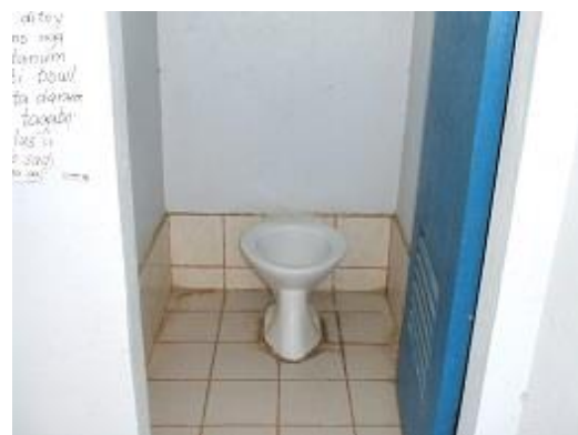
School toilet, Ilocos Sur
