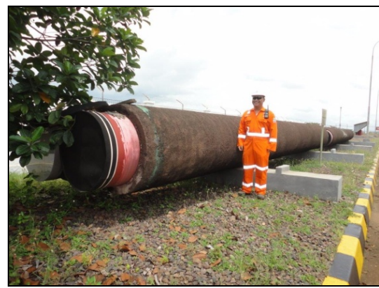
Spare Pipe (Cilegon)
