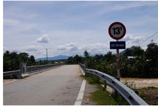
Tam Ngan Bridge At the time of Ex-post Evaluation (2017)
