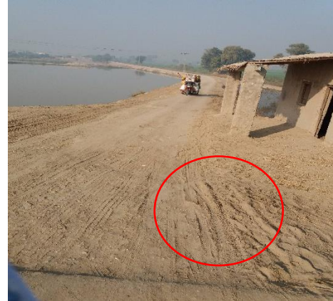
Bad condition road Dadu (DA - 3)
