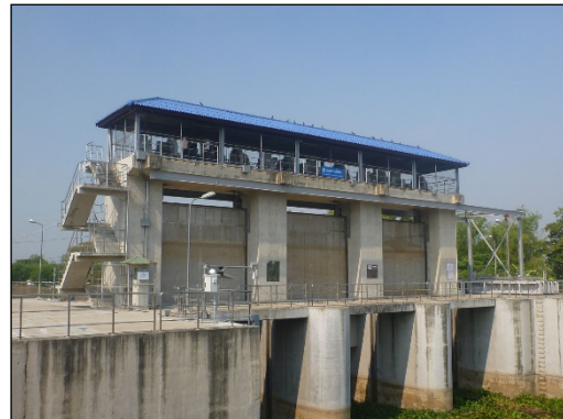
Han Tra Floodgate
