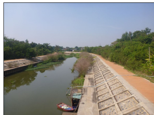
Photo 1: Revetment on Han Tra Canal
