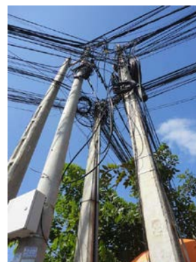
Local Access Cable (overhead line)
