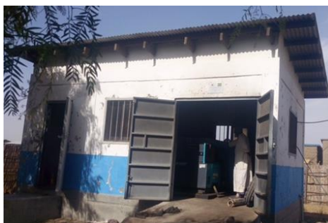
Generator House (Mito)
