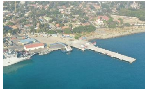
New Ferry Terminal (source: Administração dos Portos de Timor- Leste (APORTIL))
