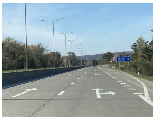
Constructed Road (Kutaisi-Samtredia)
