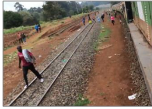
キベラ駅 信号・車軸検知装置の器具箱設置予定地 (2)
