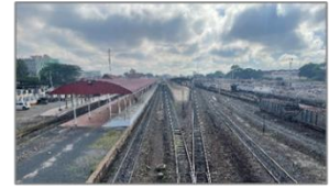
ナイロビ中央駅 信号・車軸検知装置の器具箱設置予定地 (3)
