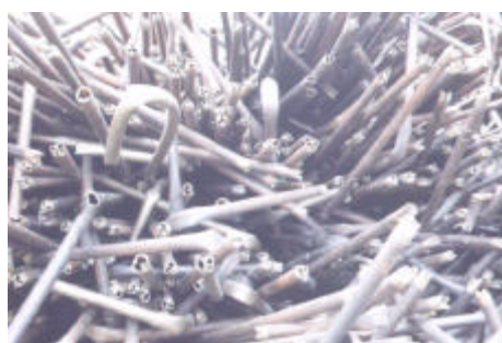
(左) 交換されたチューブ 11,780 本が構内に積まれている。(右) 冷却管の端末処理
