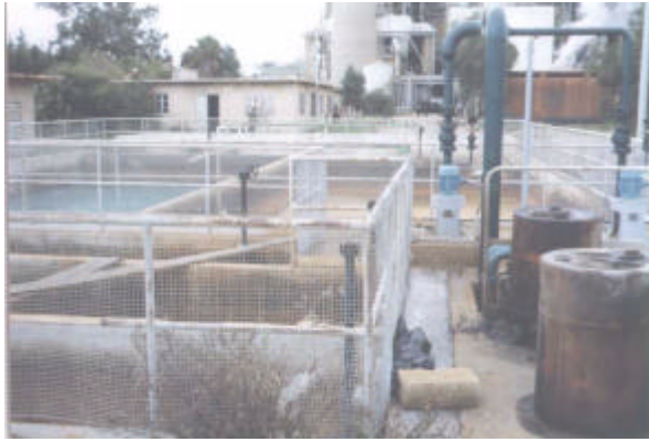
生活排水の処理槽
