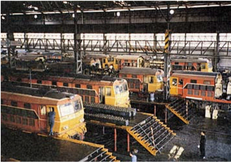
パンスー機関車基地定期点検作業風景
