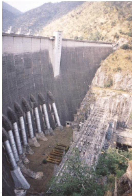
ブミボンダム発電所全景
