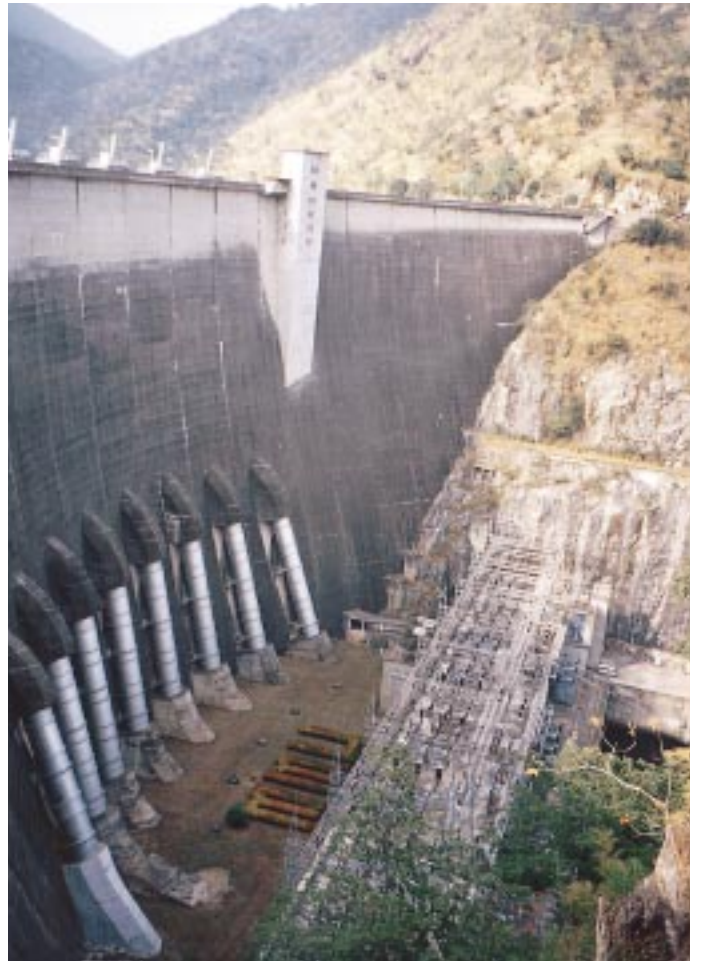
プミボンダム発電所全景
