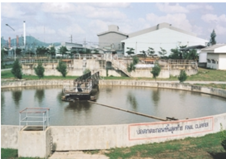
団地内にある最終下水処理場
