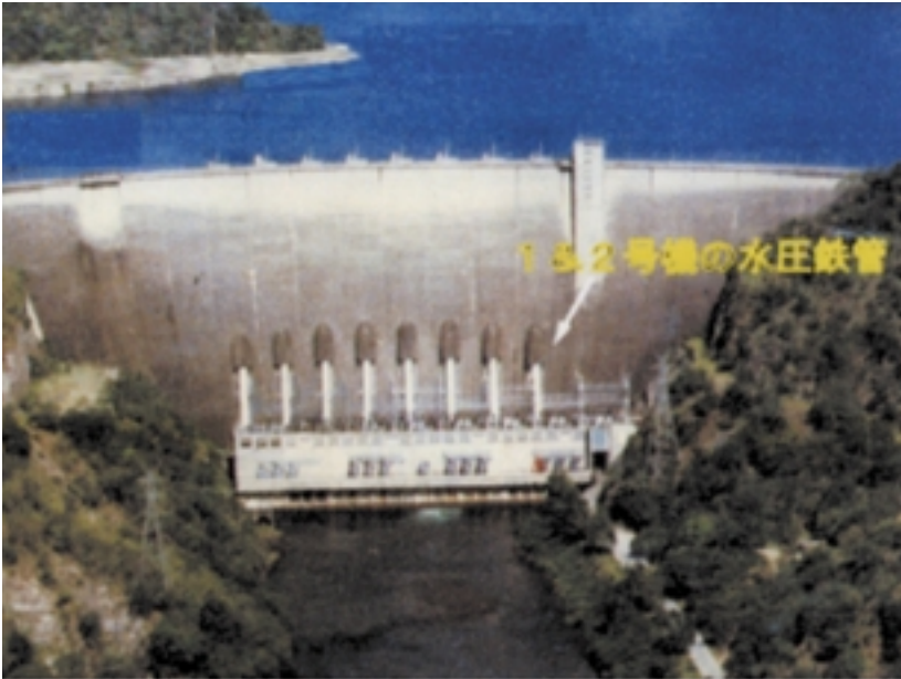
タイ「プミポン水力発電所リハビリ事業」 1 & 2号機の水圧鉄管（右の2本）
