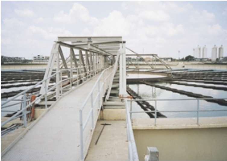
本事業により拡張されたバンケン浄水場
