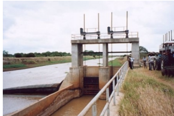
タナ・デルタ灌漑 サイロニ頭首工
