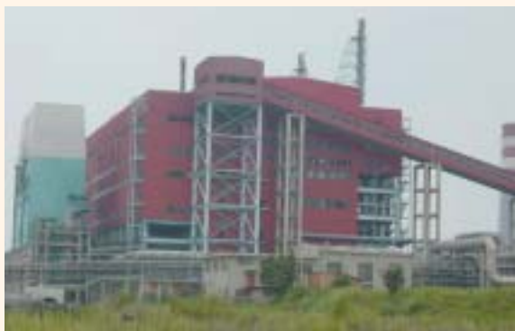
本事業により建設された肥料工場
