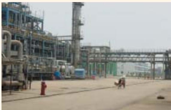
九江化学肥料工場主要設備
