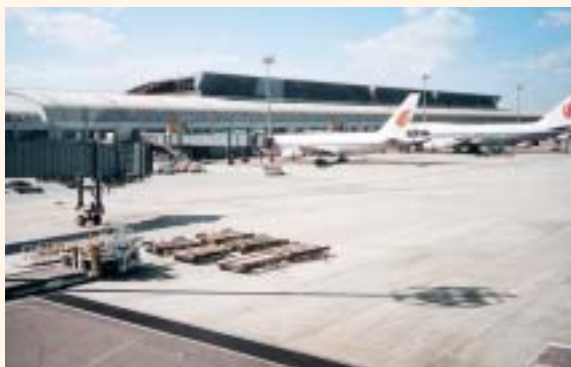
本事業により整備された北京首都空港
