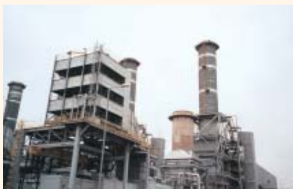
コンバインド・サイクル発電所
