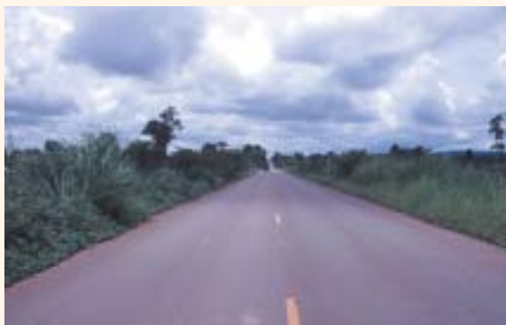
本事業により改良された道路（ウドンタニ近郊）
