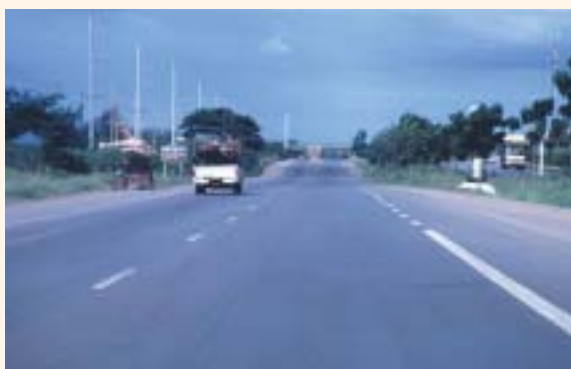
本事業により拡幅された国道35号線
