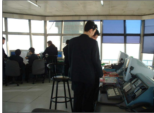
本事業により調達された機器(北京空港管制塔)
