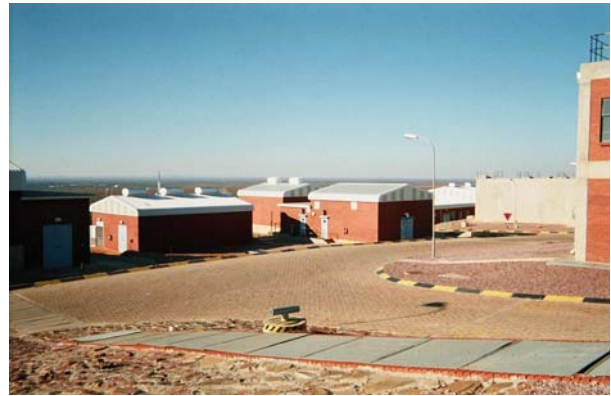
ママシア浄水場
