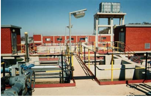
マハラピエ浄水場
