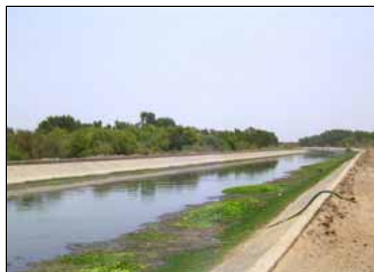
本事業により整備された水路砂防林
