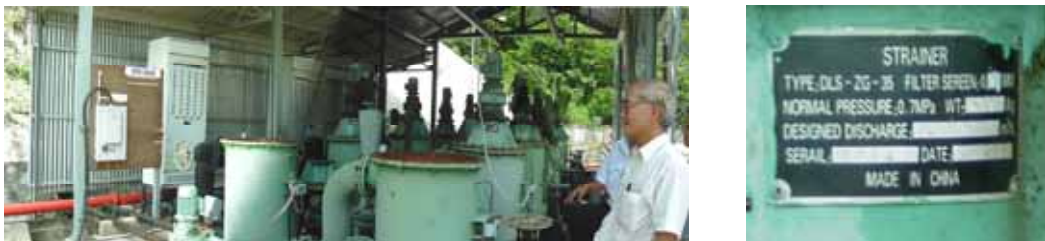
図 6： 砂分離装置
