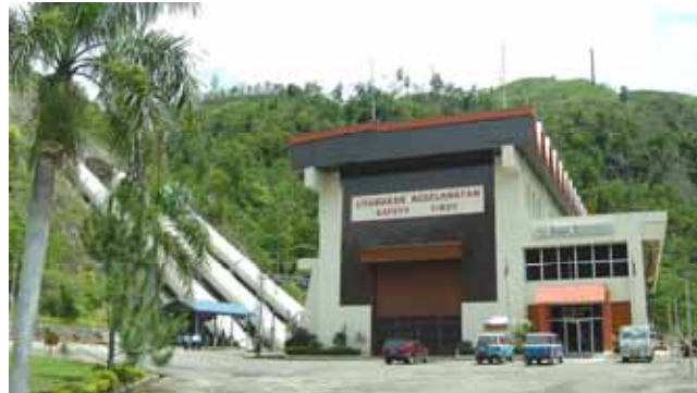
テノンパンギ水力発電所建家正面
