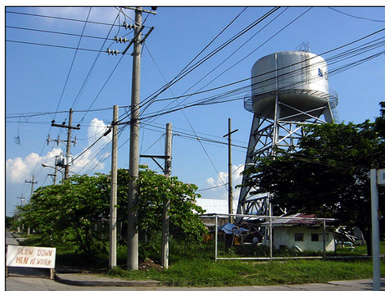
本事業で建設された給水塔と配電施設
