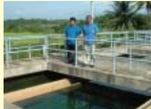
パタルンの浄水場
