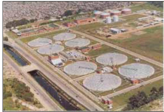
下水処理場全景
