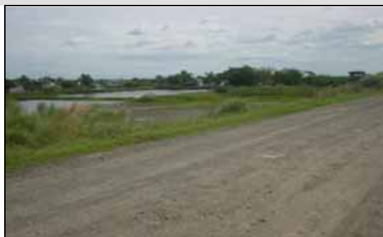
本事業にて整備された堤防道路
