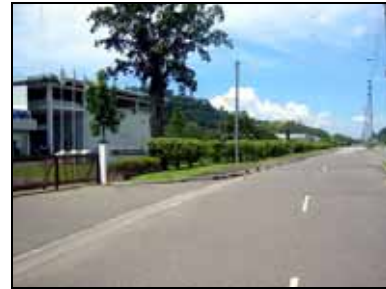
図 8 スービック自由港区の工業団地
