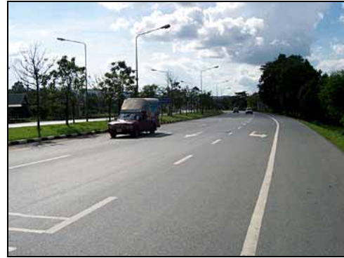
本事業により拡幅された道路
