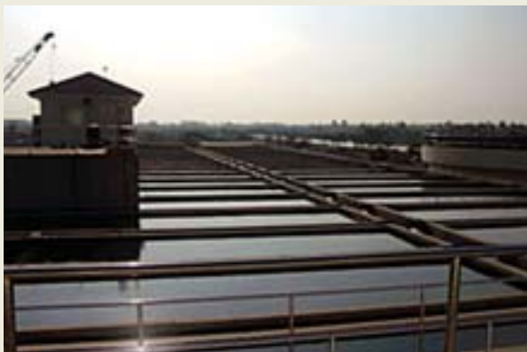
本事業により新設されたマハサワット浄水場
