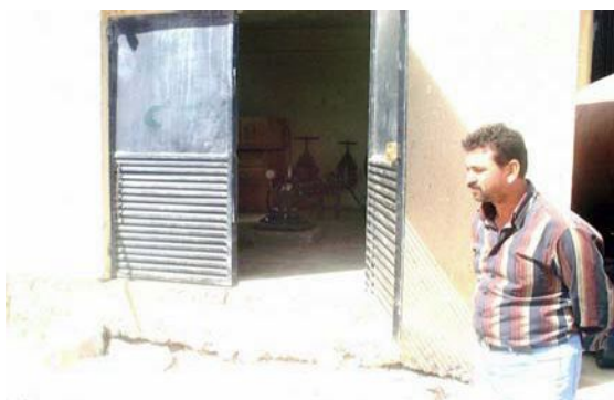
取水ポンプ場（機材はわが国が整備を行い、 建屋はシリアが建設。施錠されておりセキュ リティ対応がなされている。）
