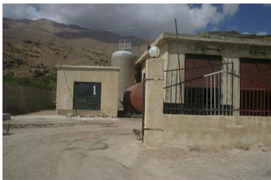
ヘルモン山頂付近の取水・送水ポンプ場全景 (左の小屋が取水施設、右の建物が送水施設)
