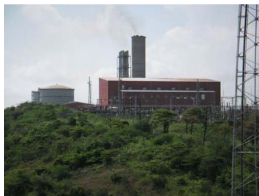
キペペI火力発電所 1 遠景
