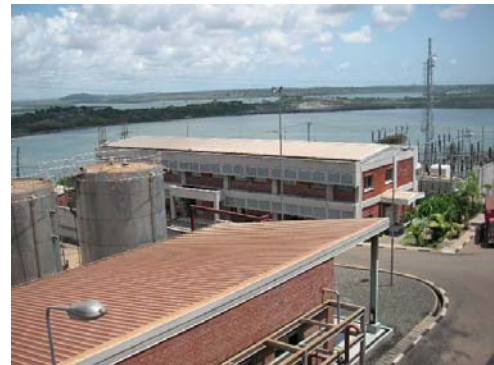
図 5 発電所の事務棟
