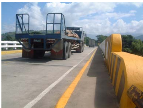
大型トラックが往来するインディアナ橋
