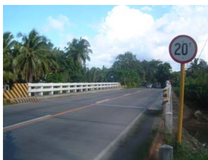
タラバ橋に設置された重量制限標識
