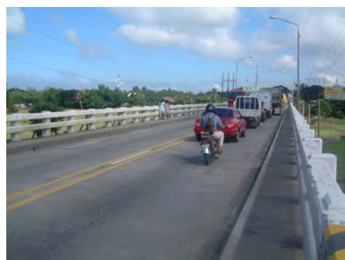
第2期で改修されたバウアン II 橋
