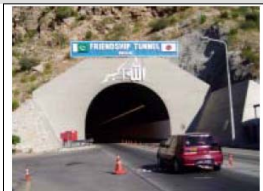
コハットトンネル
