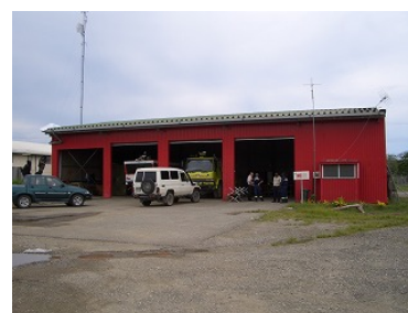
移設された消防車庫
