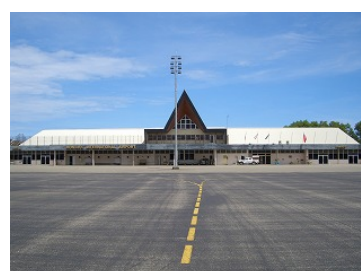
ターミナルビルに続くエプロン
