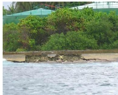
波浪に脆弱な従来工法による護岸（マレ島に隣接するタンク島の護岸）
