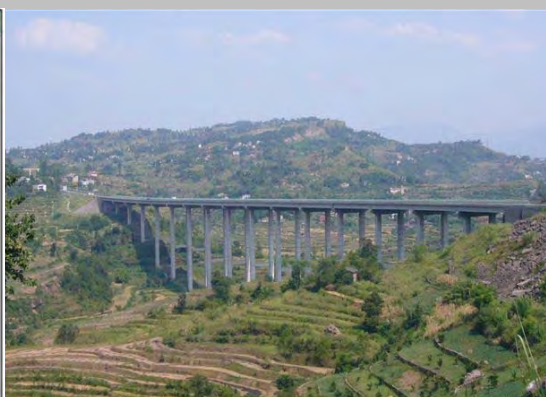
万県梁平高速道路万州（終点）付近の高架橋
