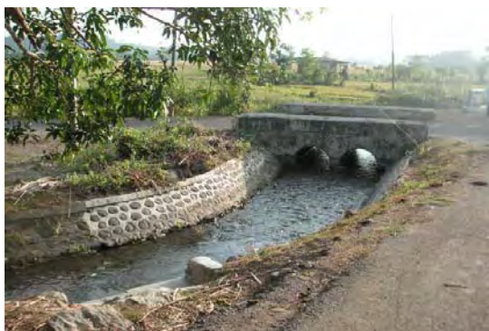
修復された灌漑2次水路
