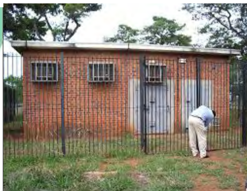
建設された局舎
