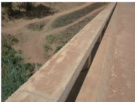
欄干（ひび割れ補修済み）
