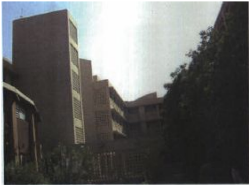
1. 多目的実習棟
