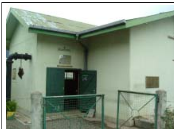
送水ポンプ場
